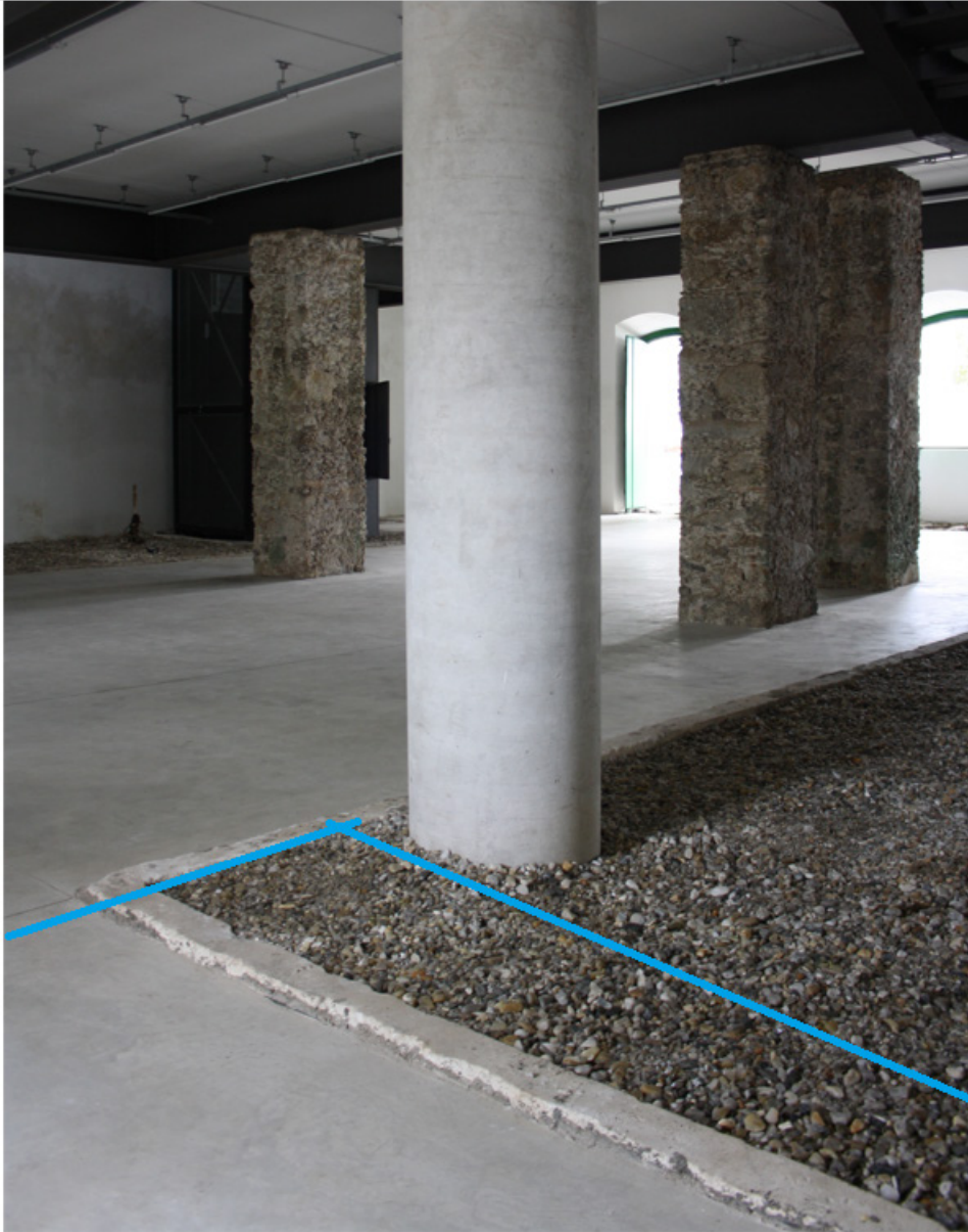
Delimitação de trecho de piso em concreto armado polido a ser refeito para aumento da área da recepção e embutimento de instalações no piso.
