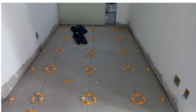
Colocação de piso de porcelanato
