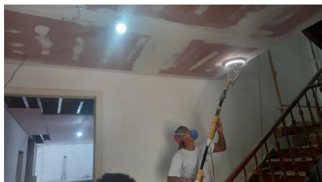
Lixamento de forro para aplicação de massa corrida
