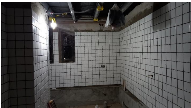
Colocação de revestimento cerâmico no sanitário do subsolo
