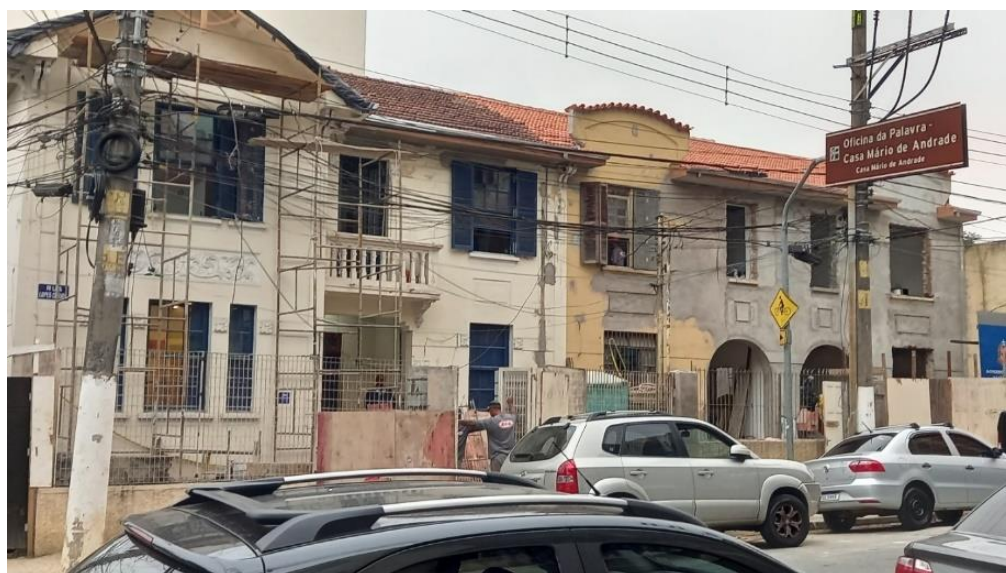
Vista da fachada frontal após reforma do beiral e revisão da argamassa
