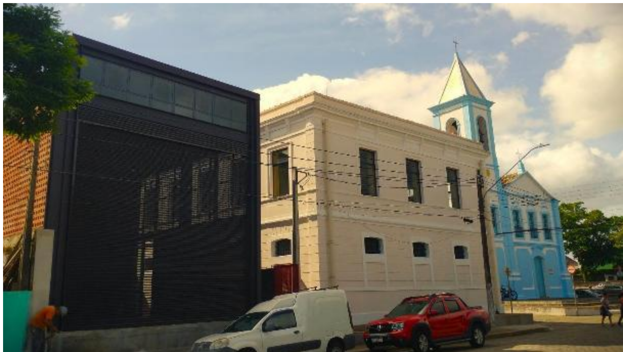
Unidade Cadeia Velha em Iguape, composta por Prédio Histórico restaurado e Prédio Anexo construído.
